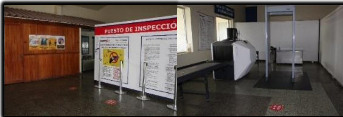
Puesto de inspección de pasajeros
