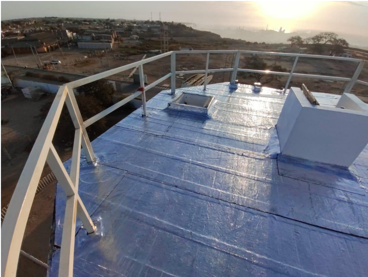
MANTENIMIENTO TECHO TORRE DE CONTROL
